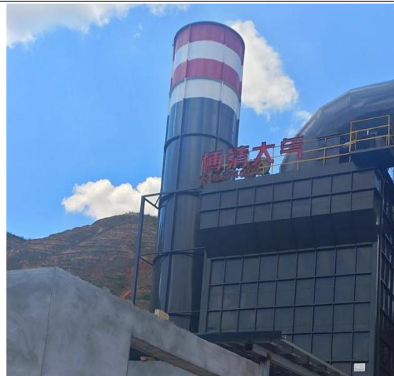
隧道窑除尘器、排气筒
