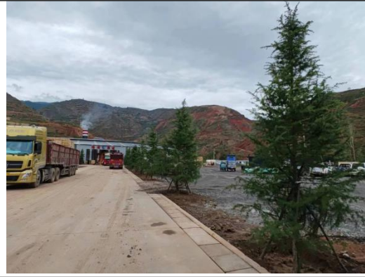
厂区道路硬化
