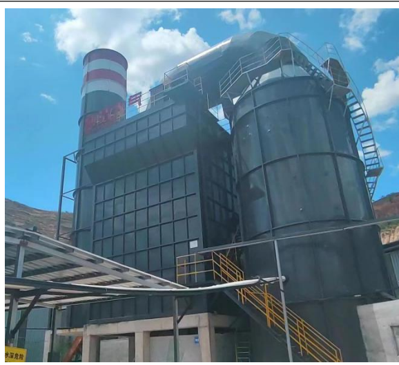
隧道窑除尘器、排气筒
